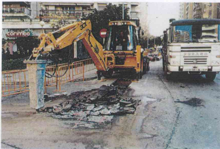
DEMOLICIÓN MECANICA DE PAVIMENTO ASFALTICO
