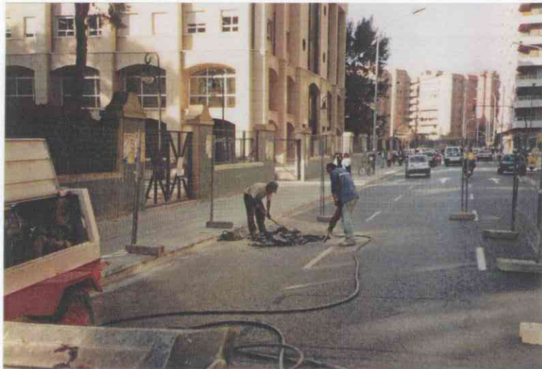
DEMOLICIÓN MANUAL LOCALIZACIÓN DE SERVICIOS
