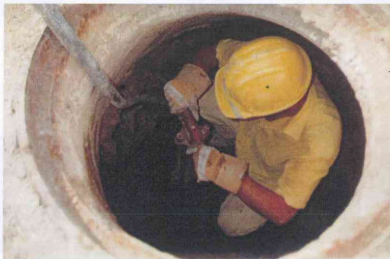
DEMOLICIÓN MANUAL EN INTERIOR DE POZO
