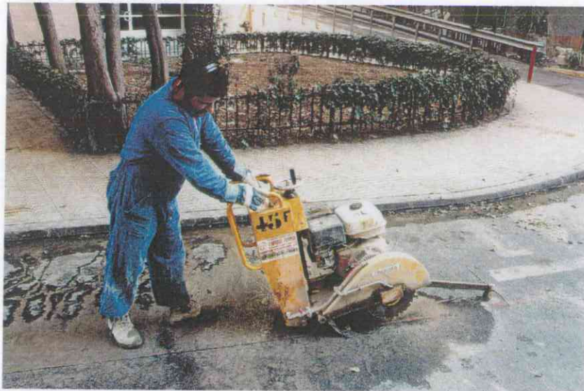
CORTE DEL PAVIMENTO ASFALTICO
