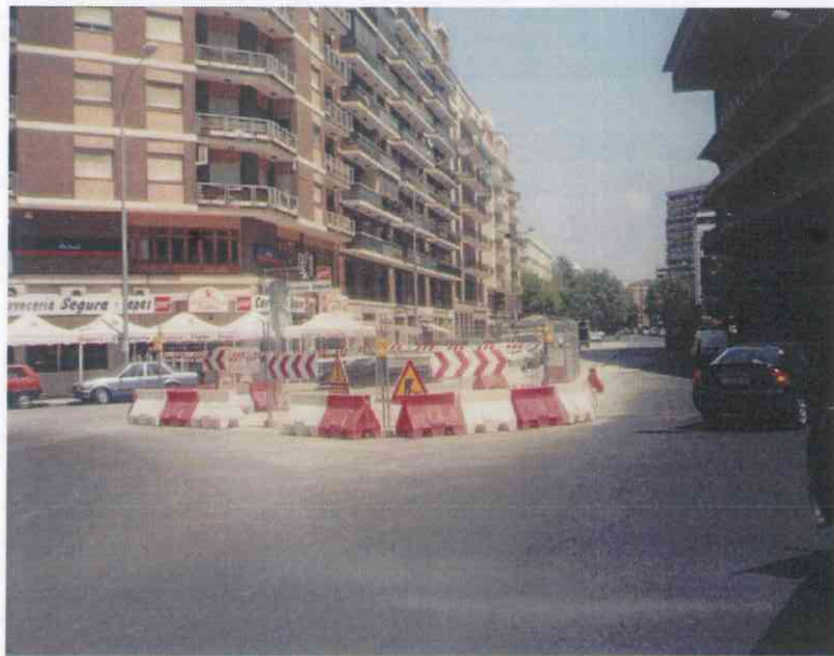
SEÑALIZACIÓN EN REFORMA DE ISLETA
